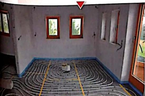
La bioedilizia privilegia l'impianto di riscaldamento funzionante tramite una serie di tubature, dette **serpentine**, posate sotto la pavimentazione e alimentate a basse temperature (circa 40 °C). Con questo sistema si riscalda uniformemente lo spazio interno, non si solleva il pulviscolo e si mantiene il corretto grado di umidità dell'aria.
