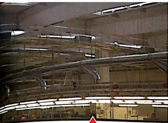
Alcuni impianti termici impiegano, per il trasporto del calore, grossi tubi in lamiera dove circola l'aria, utilizzati prevalentemente all'interno di grandi edifici come industrie, magazzini, supermercati.
