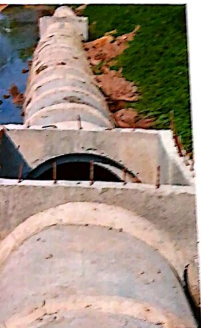
Alcune tubature esterne conducono le acque di scarico alle fognature e agli impianti di depurazione.
