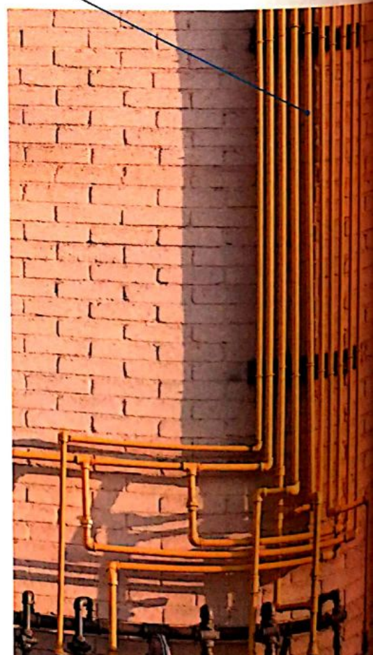
I tubi del gas si trovano all'esterno degli edifici per ragioni di sicurezza
