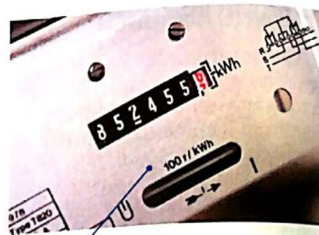
Contatore per il consumo di energia elettrica. I consumi vengono conteggiati in kilowattora (Kw/h)
