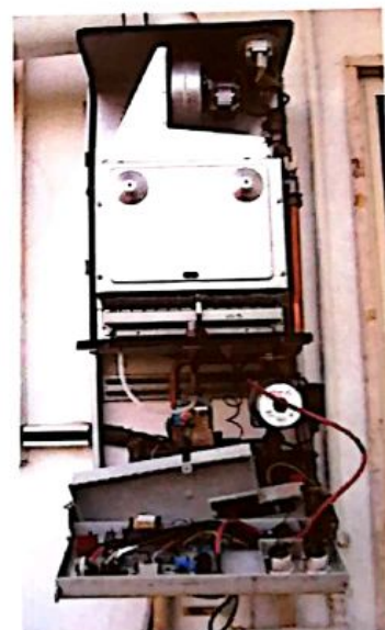
Veduta dei componenti tecnici (meccanici, elettrici, idraulici) di una caldaia a metano, privata dell'involucro di copertura.
